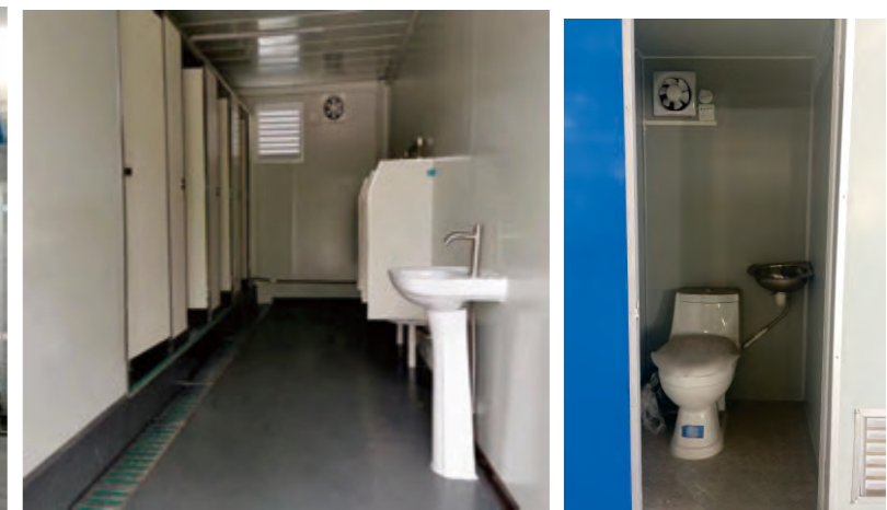
Container toilet Inside
