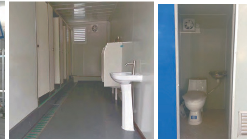
Container toilet Inside
